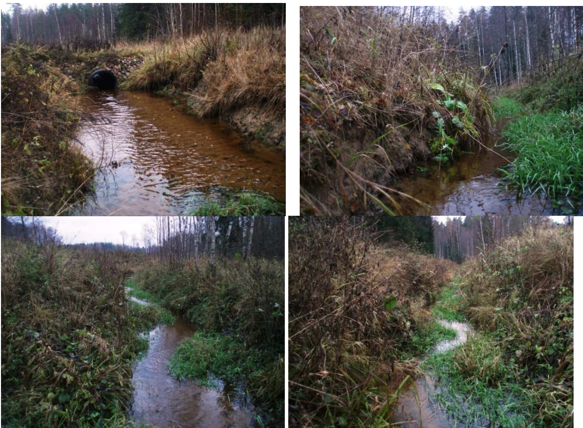
Joonis 4.3. Kraavinõlva uhtumine ja voolusängi setetega ummistumine Särgjärve objektil.
